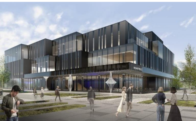
Конгресс-центр Ввод – 2025 г.
