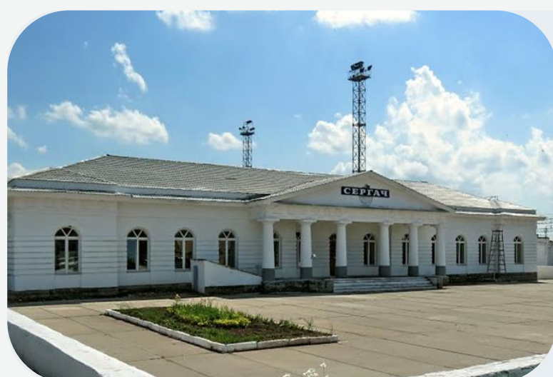
Здание вокзала в г. Сергач
